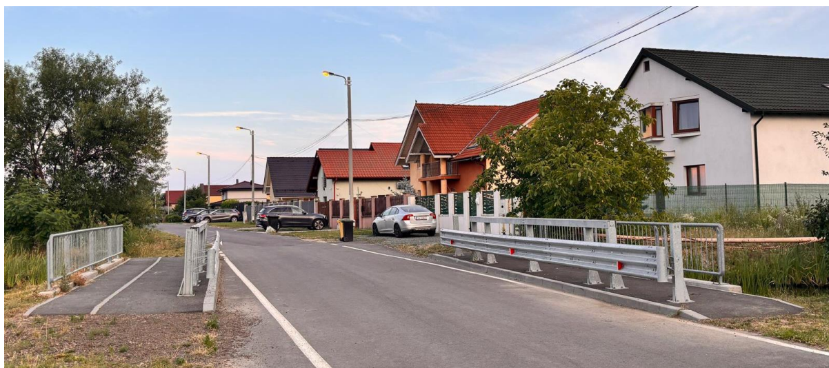
Lucrările executate peste podeț pe baza A.C. nr. 201/2021 (sursă: PMT)
